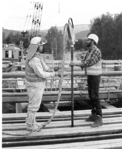
Bild 6. Herstellen der Bohrlöcher mit dem Hochdruckwassergerät
