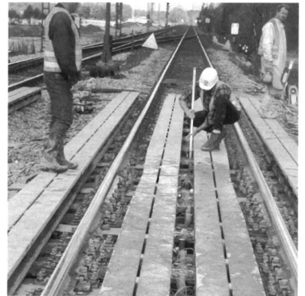
Bild 8a. Laden der Bohrlöcher zwischen den Gleisen
